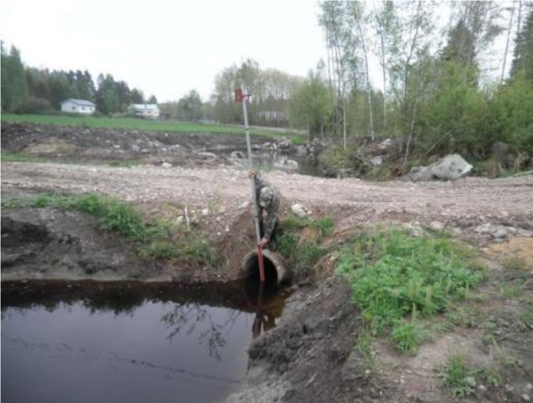
Samassa yhteydessä myös peltotien alittava rumpu asennettiin alemmas.
